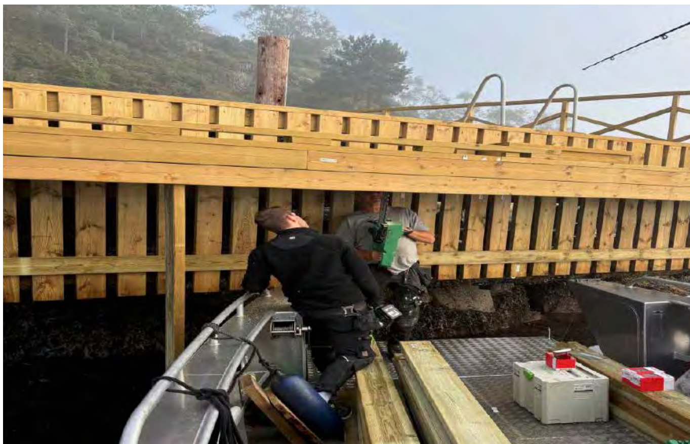
Rehabilitering av kai Vikholmen.
