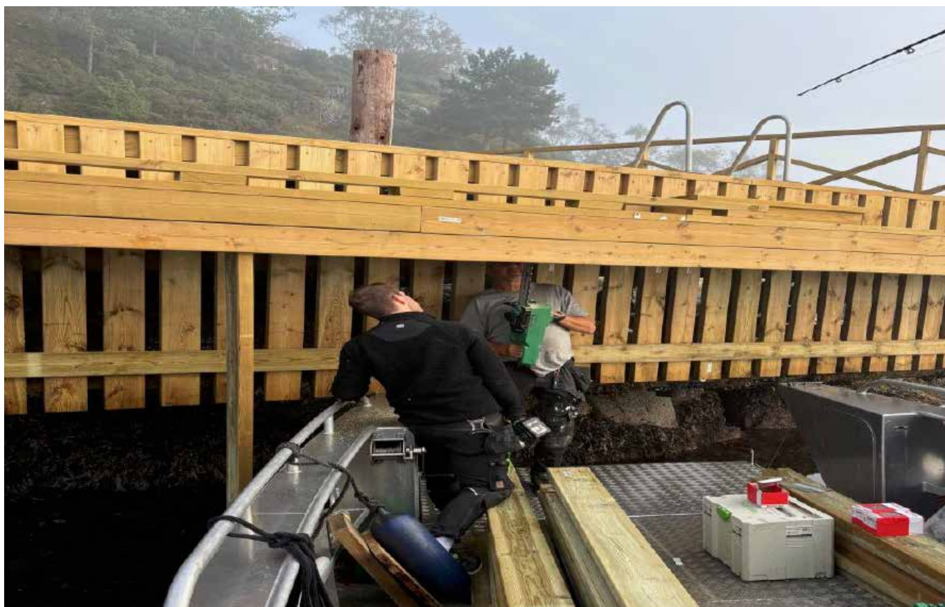
Rehabilitering av kai Vikholmen.
