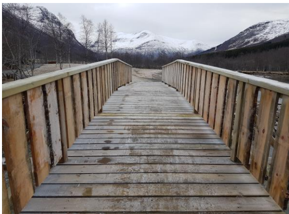
Den nye brua på Øyna i Stordal
