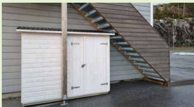
Utlånsboda under trappa til kontoret på Digerneset.
