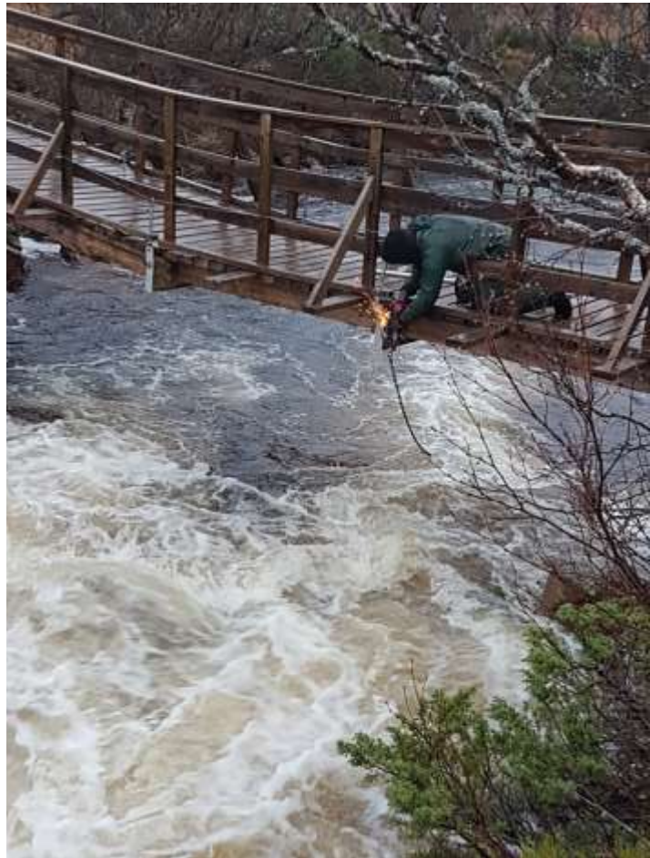
Reparasjon av Fosslibrua over Ørskogelva (Storelva) på Ørskogfjellet.
