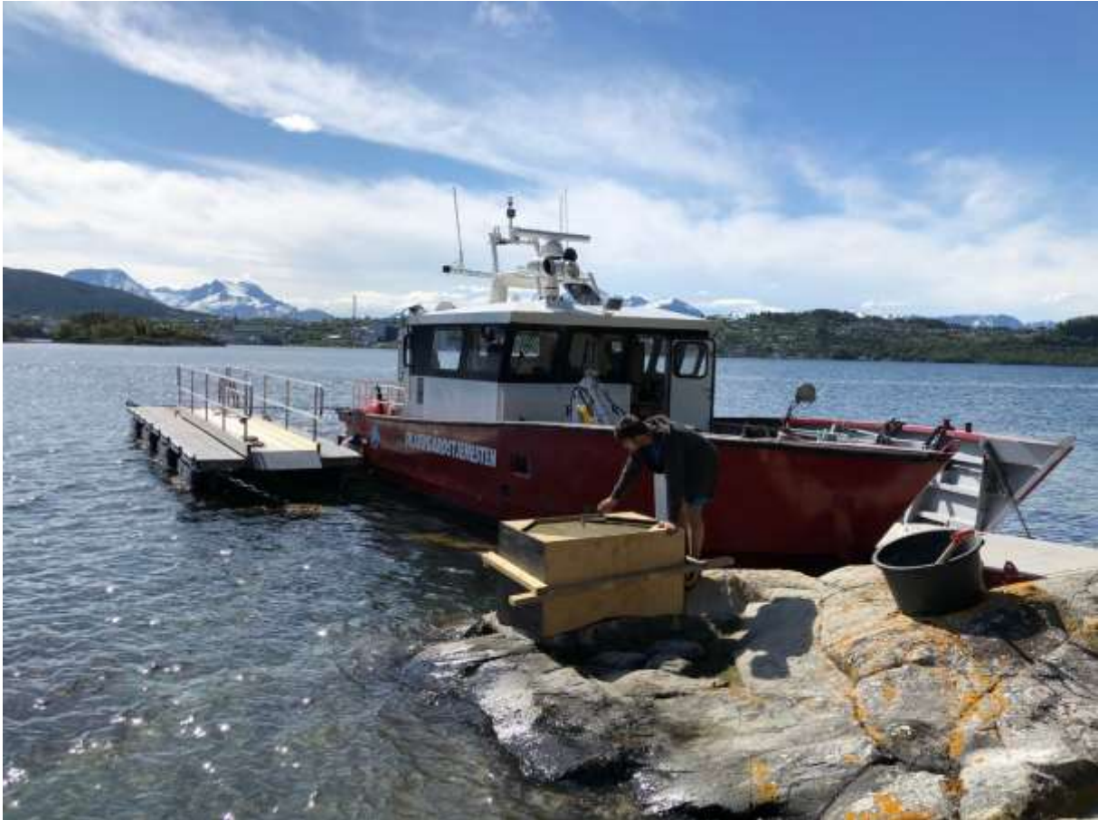
Støyping av landfeste til den nye flytebrygga på Vikholmen i Ellingsøyfjorden. Matros/driftsarbeidar Christian Ødegaard i aksjon.
