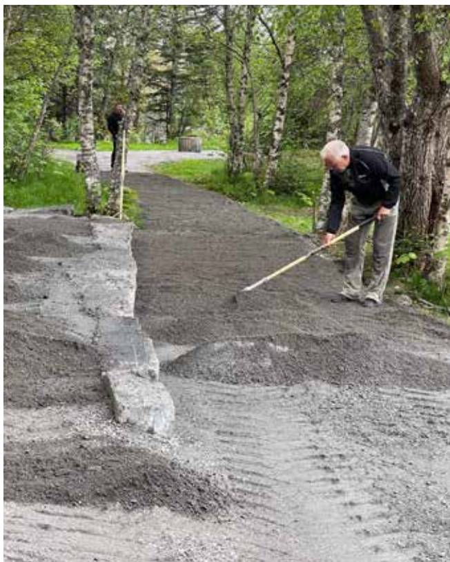
Arbeid med å gjere ferdig området rundt Grindstova slik at det også blir rullestolvenleg.
