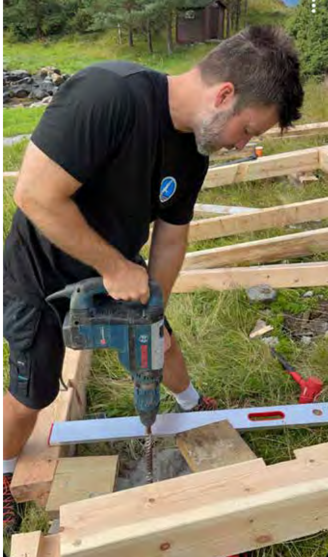
Christian Ødegaard i arbeid med å bygge gapahuk på Storholmen.
