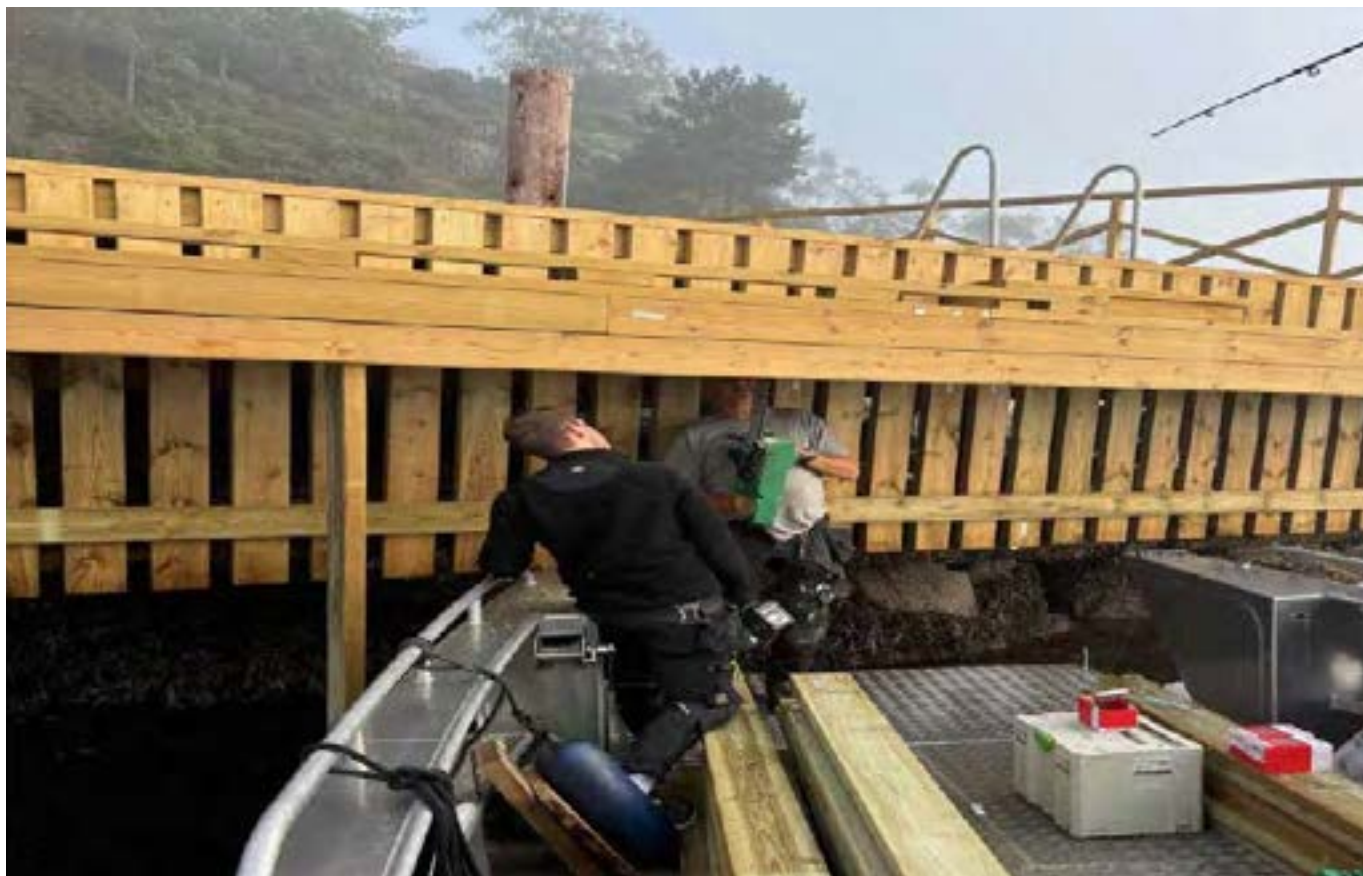
Rehabilitering av kai Vikholmen.
