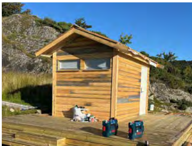
Nytt toalettbygg på øya Hundsvær i Borgundfjorden.
