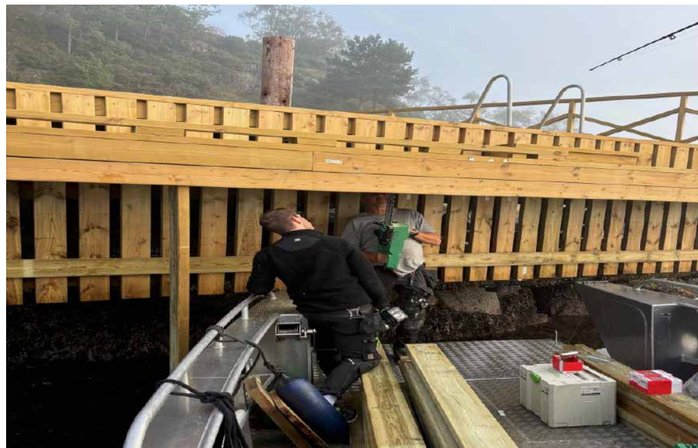
Rehabilitering av kai Vikholmen.
