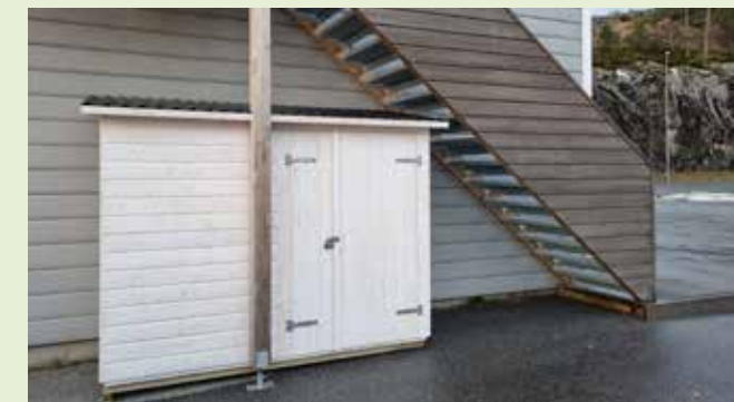
«Utlånsboda» under trappa til kontoret på Digerneset.
