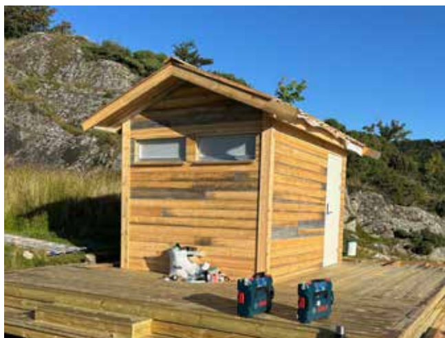
Nytt toalettbygg på øya Hundsvær i Borgundfjorden.
