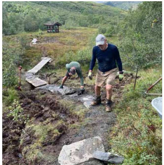
Steinlegging utført av frivillige. Friluftsrådet har bidratt med helikopterfrakt av steinen.
