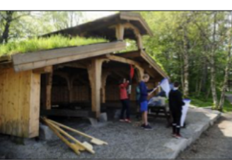
Grunntur på Stafsethneset er reist av Sunnmøre Friluftsråd og er eit populært tilhøldsted når været er ugunstig.
