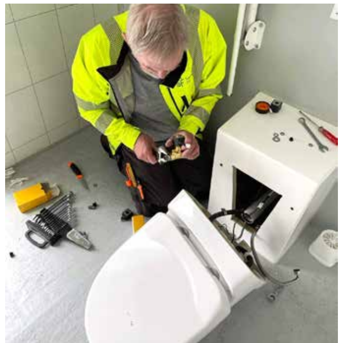
Jan Petter Lied i ferd med å reparere eitt av toaletta som har fått skade.
